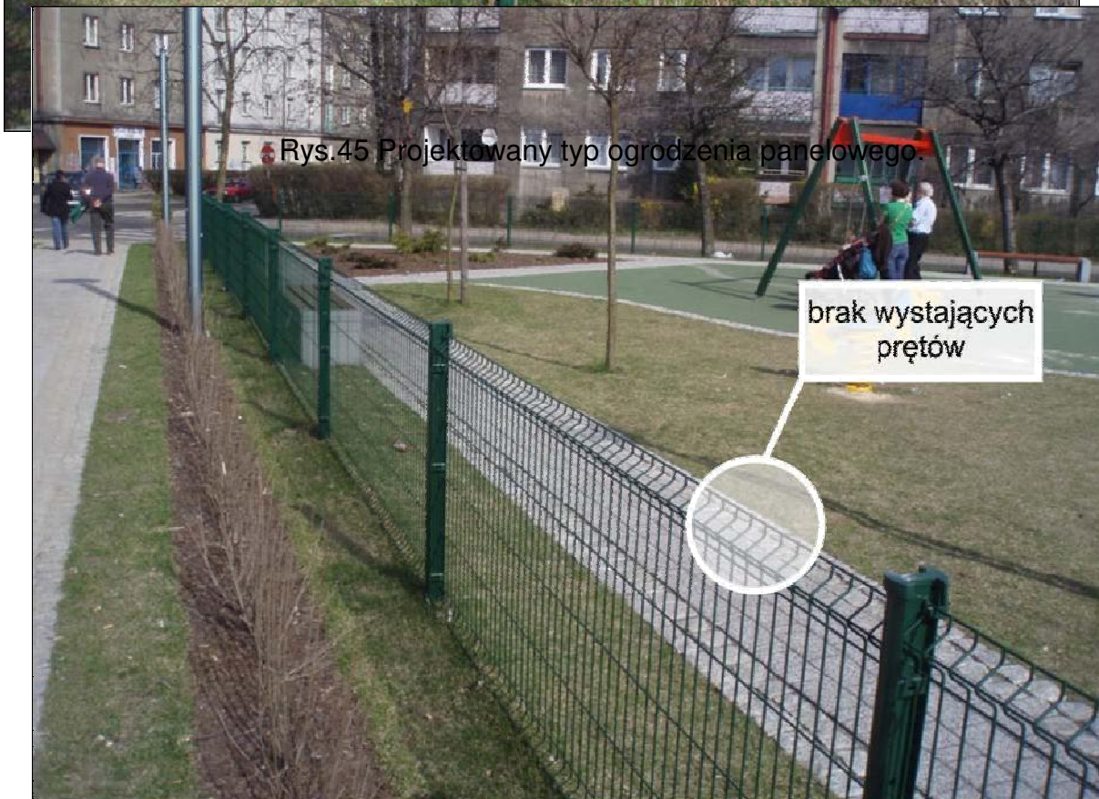
Rys.46 Projektowany typ ogrodzenia panelowego (zaznaczono miejsca gdzie absolutnie nie mogą występować pionowe pręty).
