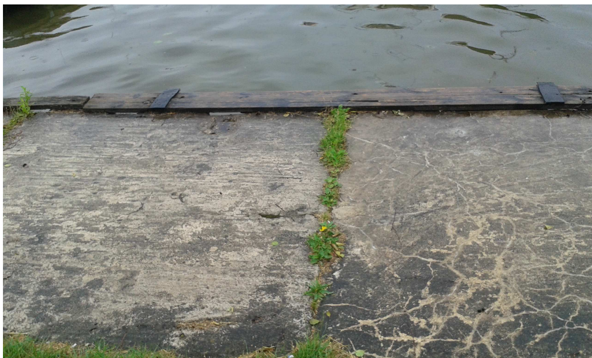
Fot. 4. Betonowe umocnienie brzegu jeziora zakończone poszyciem z desek
